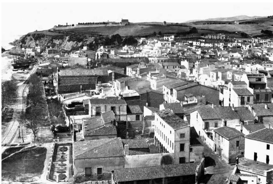
Aspecto general de la localidad de Arenys de Mar, con la estación y la vía férrea a su paso. (AHFF).
