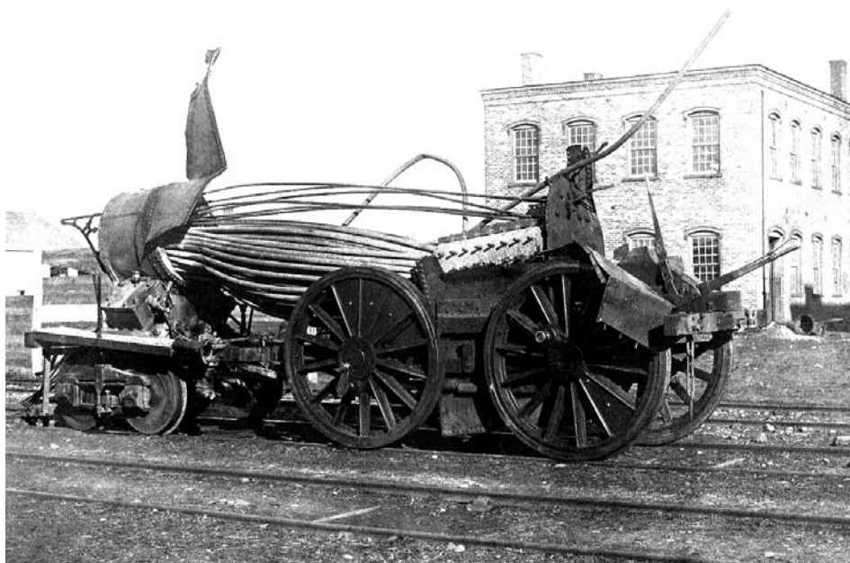
Estado de una de las locomotoras del parque de tracción del Rensselaer & Saratoga Railroad, en EEUU, tras la explosión de su caldera (LC: Library of Congress. Washington D. C. (EEUU).
