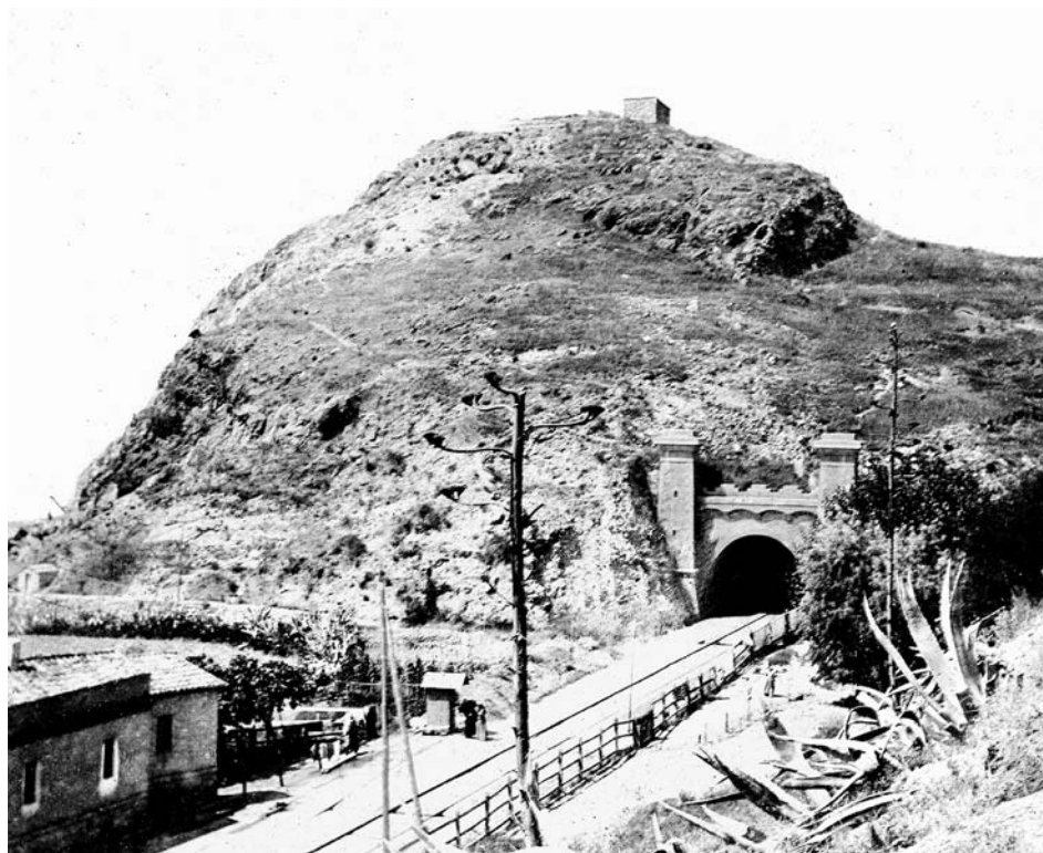
Túnel de Mongat, lado Norte, en su estado primitivo, para una sola vía (JN: Javier Nubiola. Barcelona).
