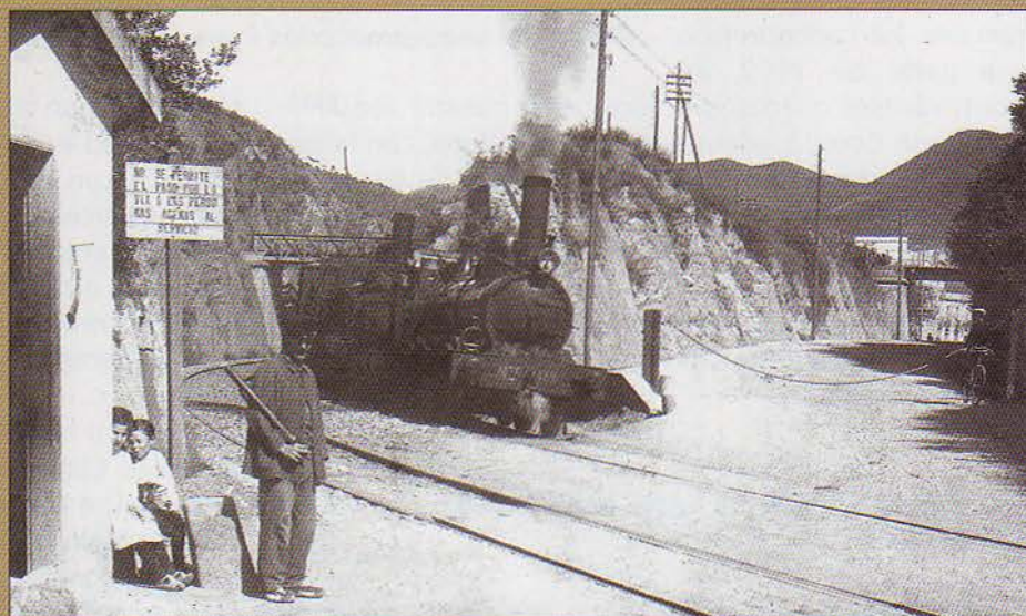
Paso a Nivel de Montcada.
